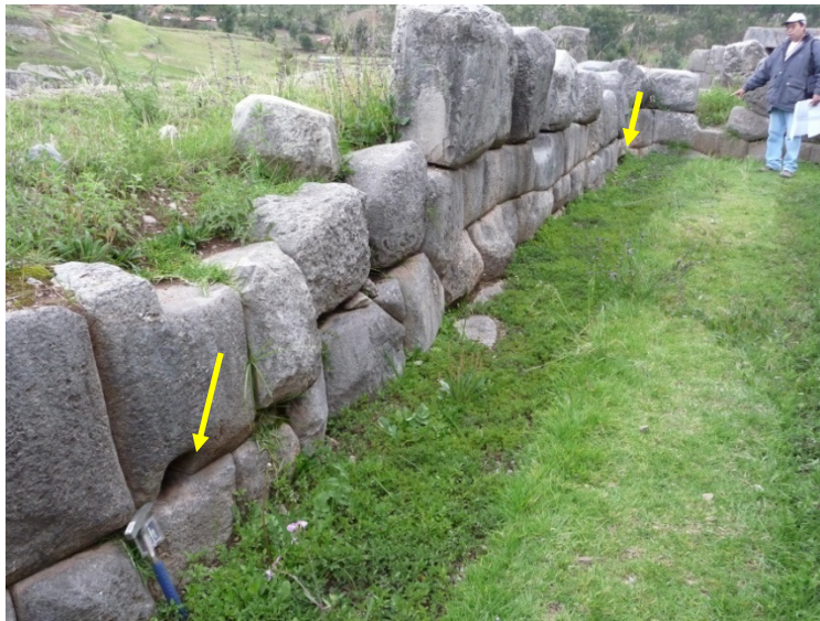
Foto 13. Drenajes a diferentes alturas del piso actual.
