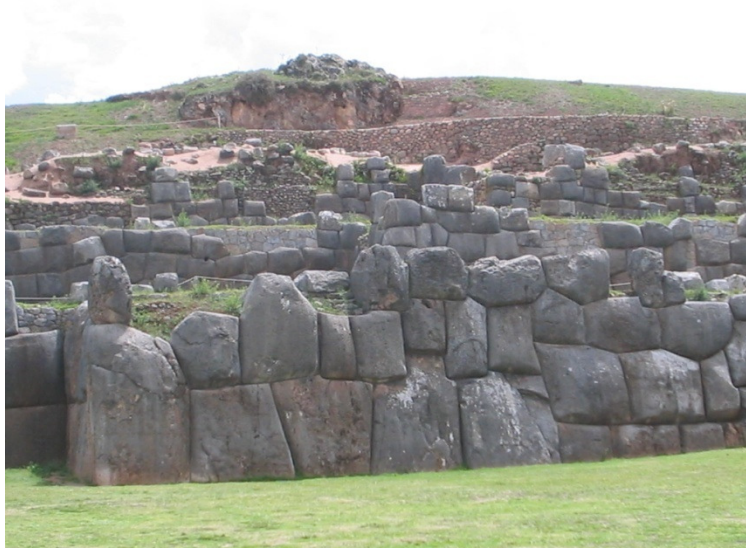
Foto 7. Bloques labrados de caliza de gran tamaño hacia la base y de menor tamaño hacia la parte superior.
