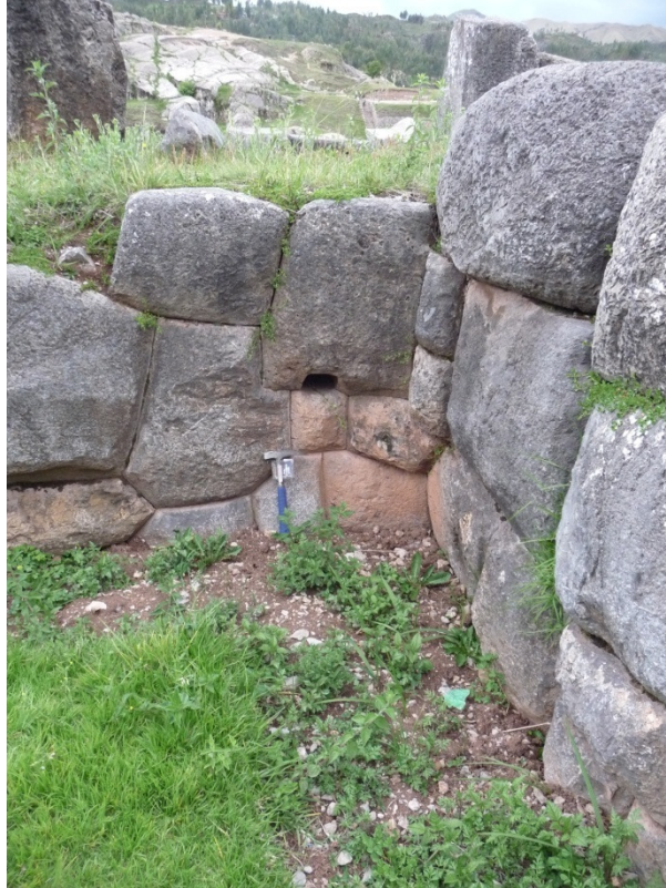
Foto 11. Drenaje en la esquina de un zigzag que se encuentra por encima del piso actual.
