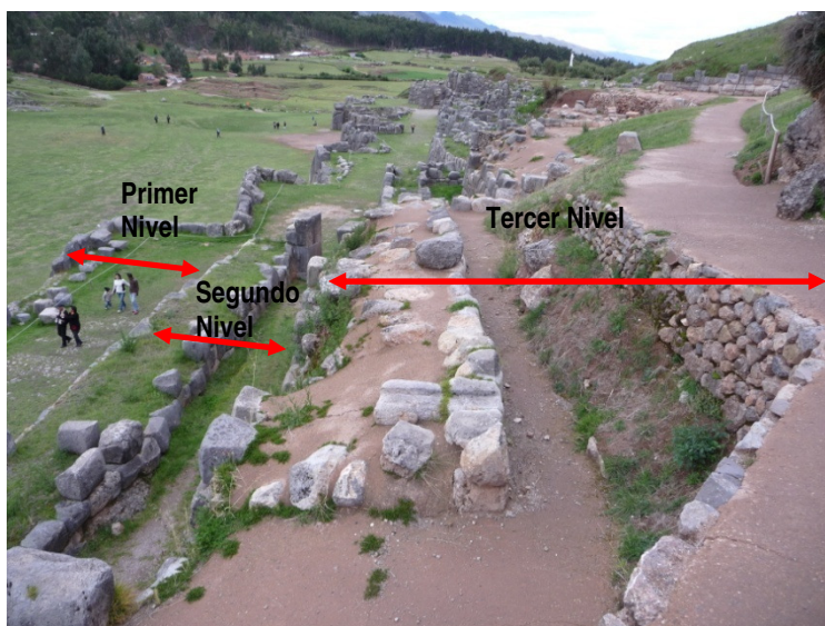
Foto 6. Muros y plataformas de los Baluartes occidentales, mostrando los 3 niveles.
